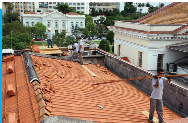
Operários trocam o madeirame e colocam novas telhas francesas na Câmara
