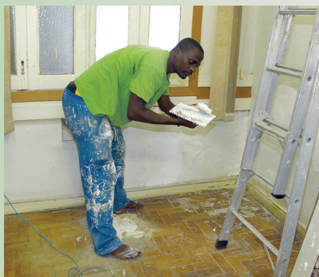
Antigos gabinetes também receberam obras de reforma
