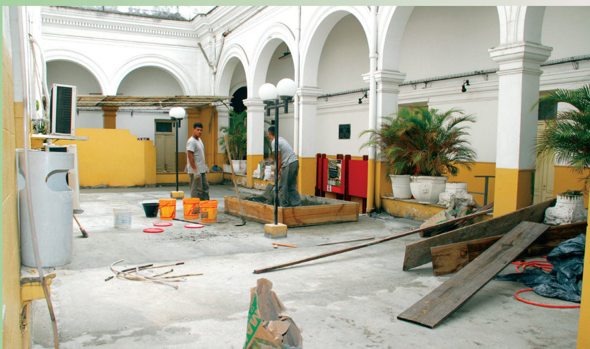
Operários impermeabilizam o piso da praça João Batista, que fica no pátio interno do prédio da Câmara de Vereadores de Niterói
